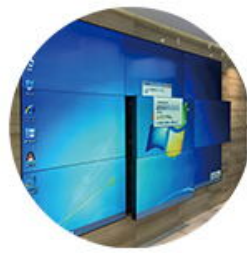
前维护支架安装
